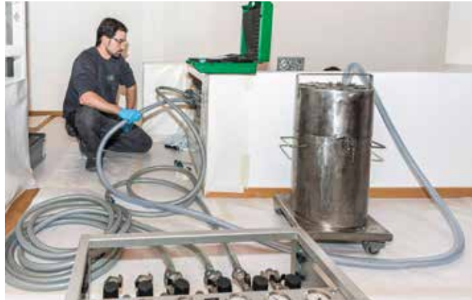
Bestehende Rohre werden von innen poliert und neu ausgekleidet.
